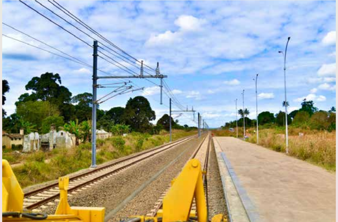
Mwonekano wa sehemu ya miundombinu ya Treni ya kisasa ya mwendokasi itakayotumia umeme (SGR), kipande cha Dar es Salaam hadi Dodoma.
