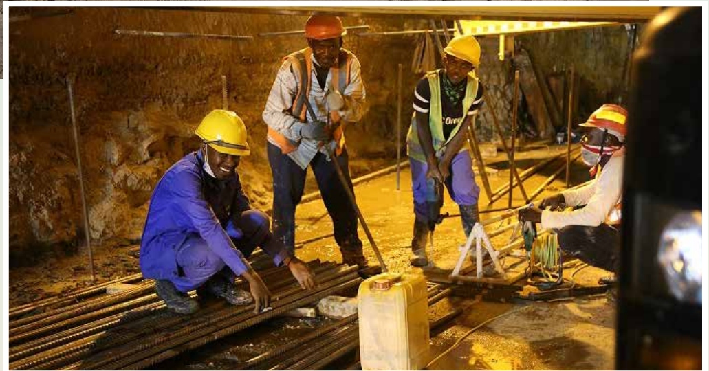
Mafundi wakiendelea na ujenzi wa Mradi wa Kufua Umeme kwa Maji wa Julius Nyerere (JNHPP) unaotekelezwa kwenye mto Rufiji, wakati wa ziara ya Naibu Waziri wa Nishati Subira Mgalu (hayupo pichani), Julai 2, 2020.
